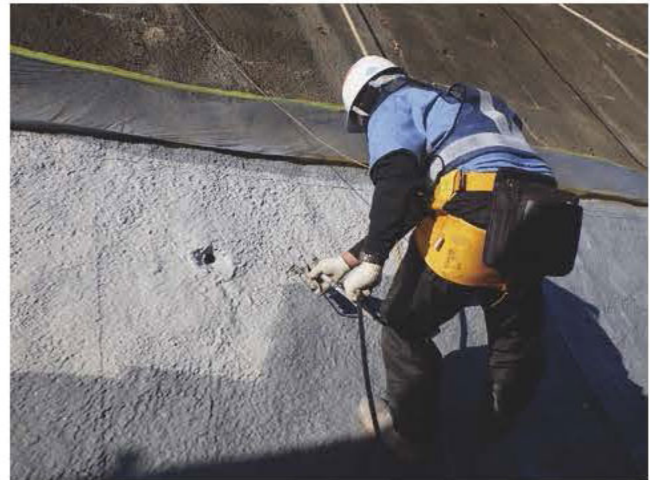
トップコート吹付工
